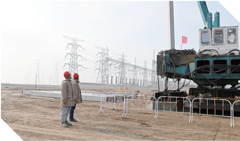
12月12日,天津南1000千伏特高压变电站扩建工程开工,图为工程现场正在进行打桩作业。 国网天津电力/供图
