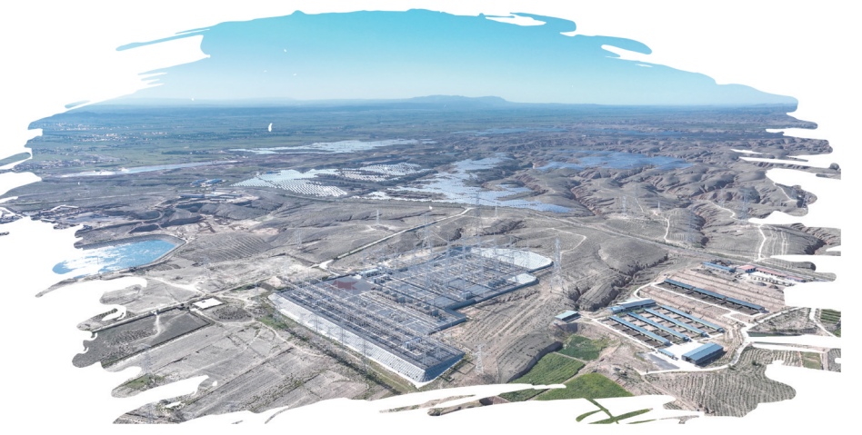
妙岭750千伏变电站新建工程及周边环境实拍图。 孙亮/摄
