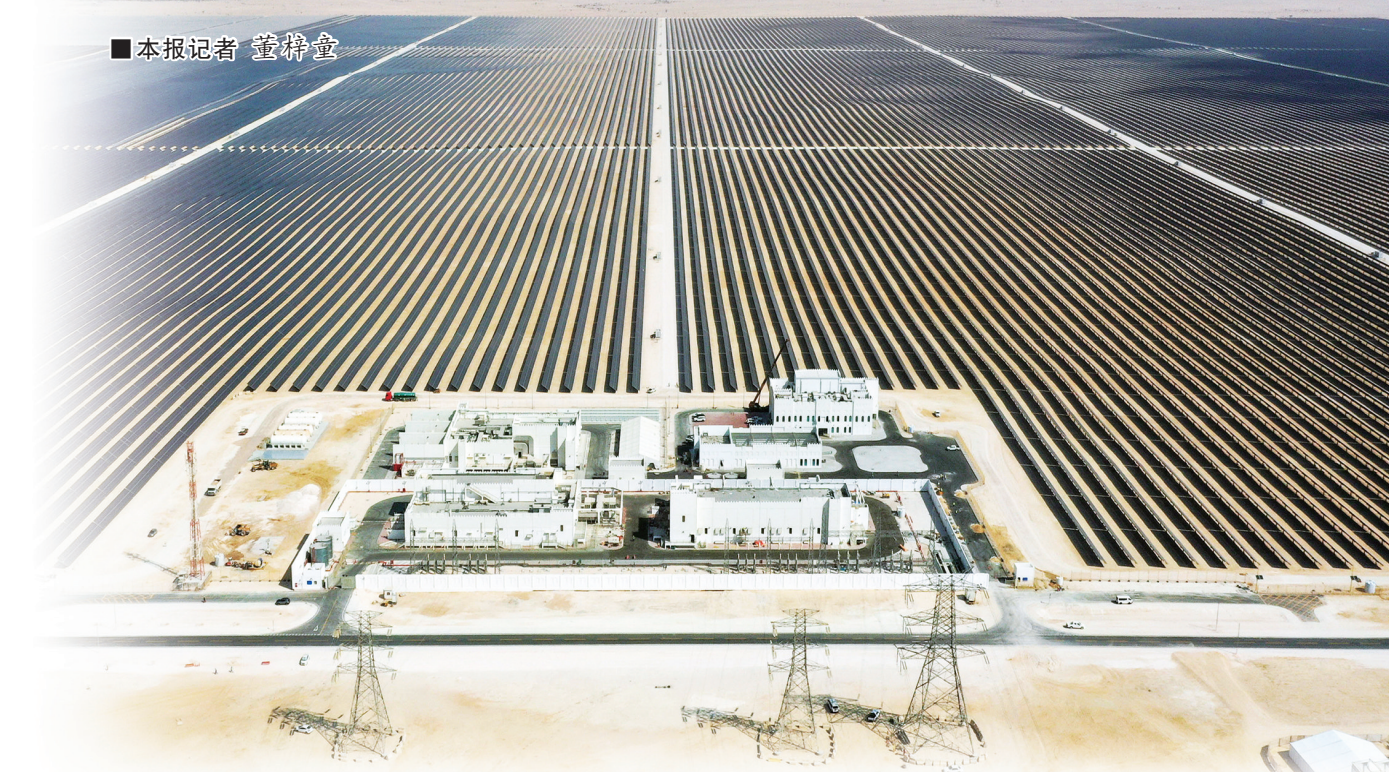
图为阳光电源卡塔尔800兆瓦光伏发电项目。阳光电源/供图
