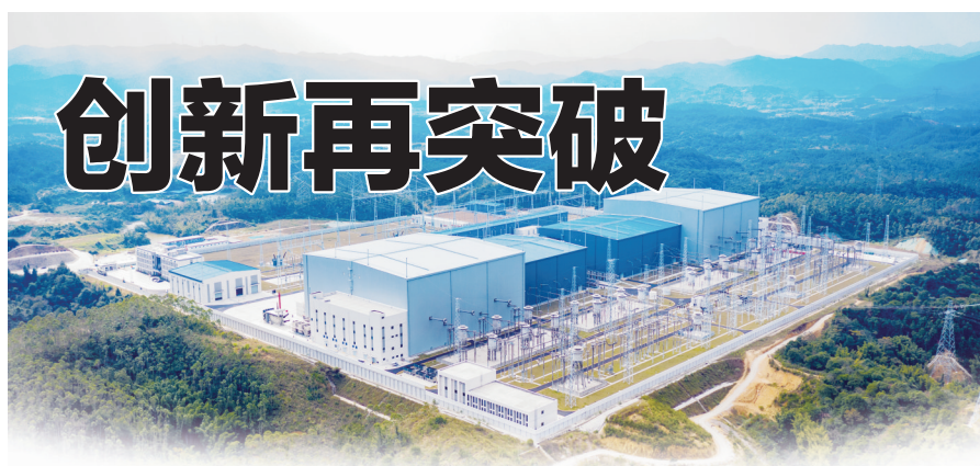
世界上首个特高压柔直换流站——±800kV龙门换流站 南网科研院/供图
