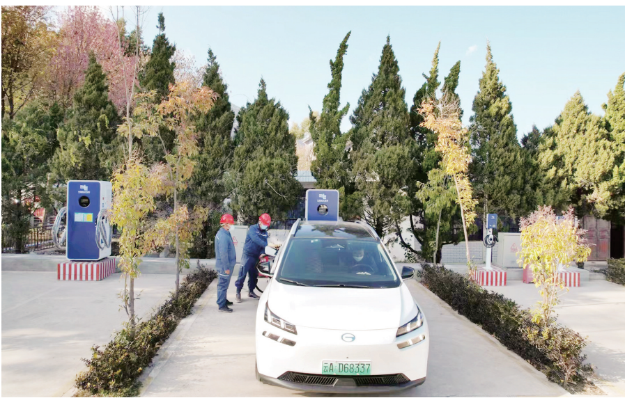
图为供电人员正在检查新建充电桩性能状况。 沙子键/摄
