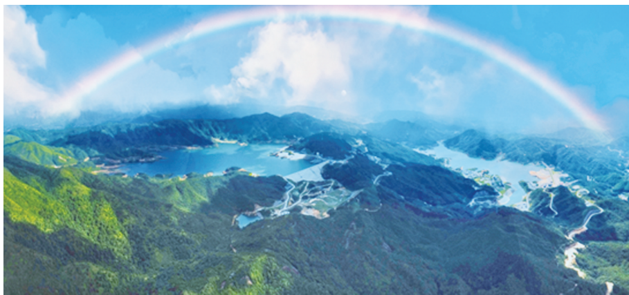
梅州抽水蓄能电站一期和二期工程共用上下水库,图为电站上下水库俯瞰图。南网储能公司/供图
