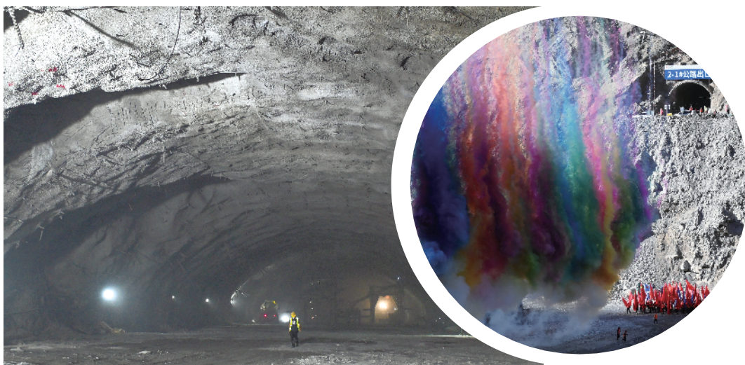
▲右岸山体内部的在建的旭龙水电站主厂房,高度将达到80米,4台共240万千瓦的水力发电机组将安装于此。 ▲旭龙水电站截流现场。国家能源集团/供图
