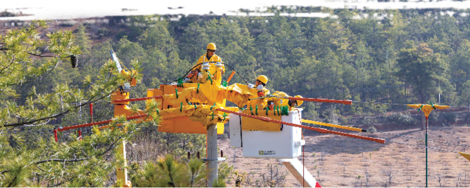
迪庆供电局员工开展带电作业。
