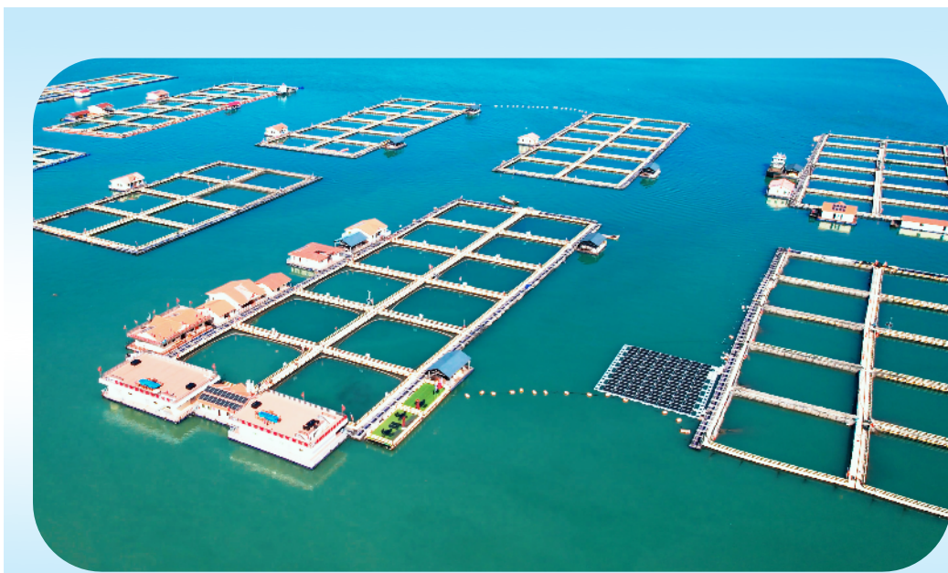
三都澳海上渔排“风光储充用”微电网示范项目。黄维禄/摄
