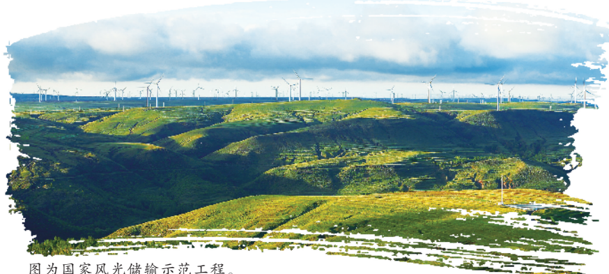
图为国家风光储输示范工程。
