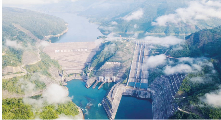
航拍华能糯扎渡水电站。华能糯扎渡水电站/供图
