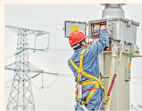
建设者在做项目调试和检查,保障顺利验收。 邓琪芳/摄
