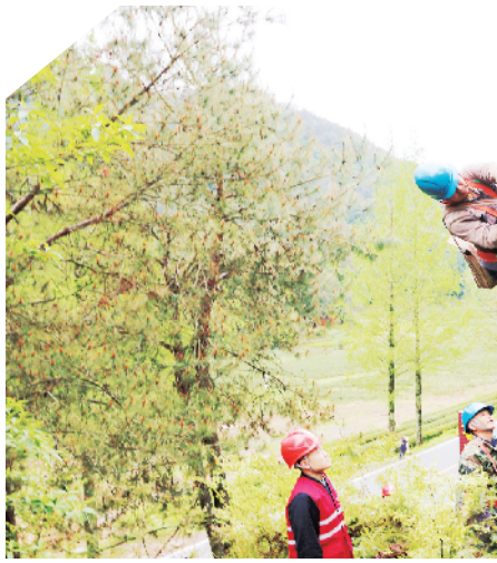
①共产党员服务队在星村镇大布岭检测低压柔直设备,保障用电可靠。 陈龙辉/摄
