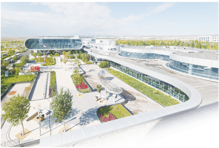
图为新疆克拉玛依云计算产业园区。截至目前，该园区已建成5座大型数据中心，拥有6万余个数据机柜，具备面向全国提供云服务的能力。视觉中国
