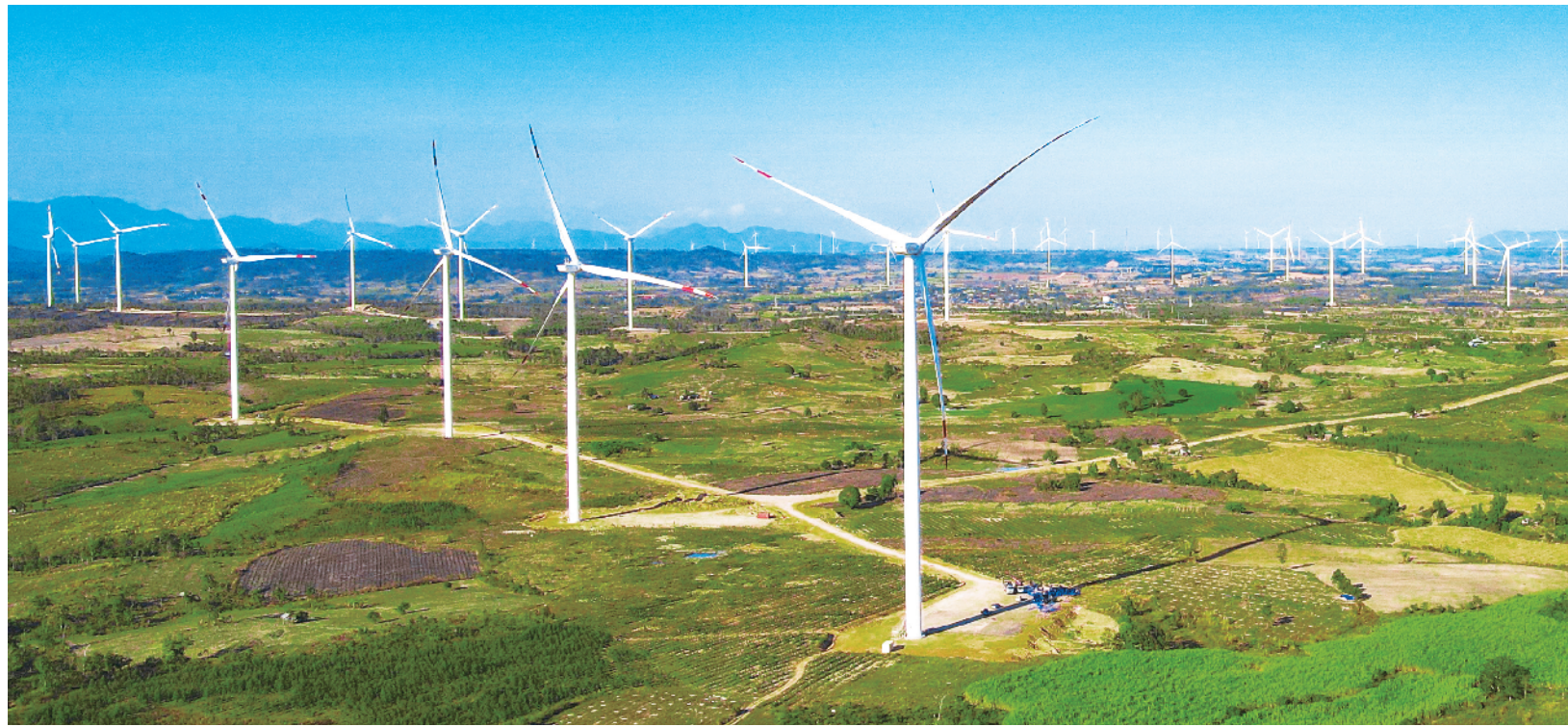
图为由中国能建广东院牵头EPC总承包建设的越南最大规模陆上风电项目——嘉莱300兆瓦风电项目。中国能建/供图
