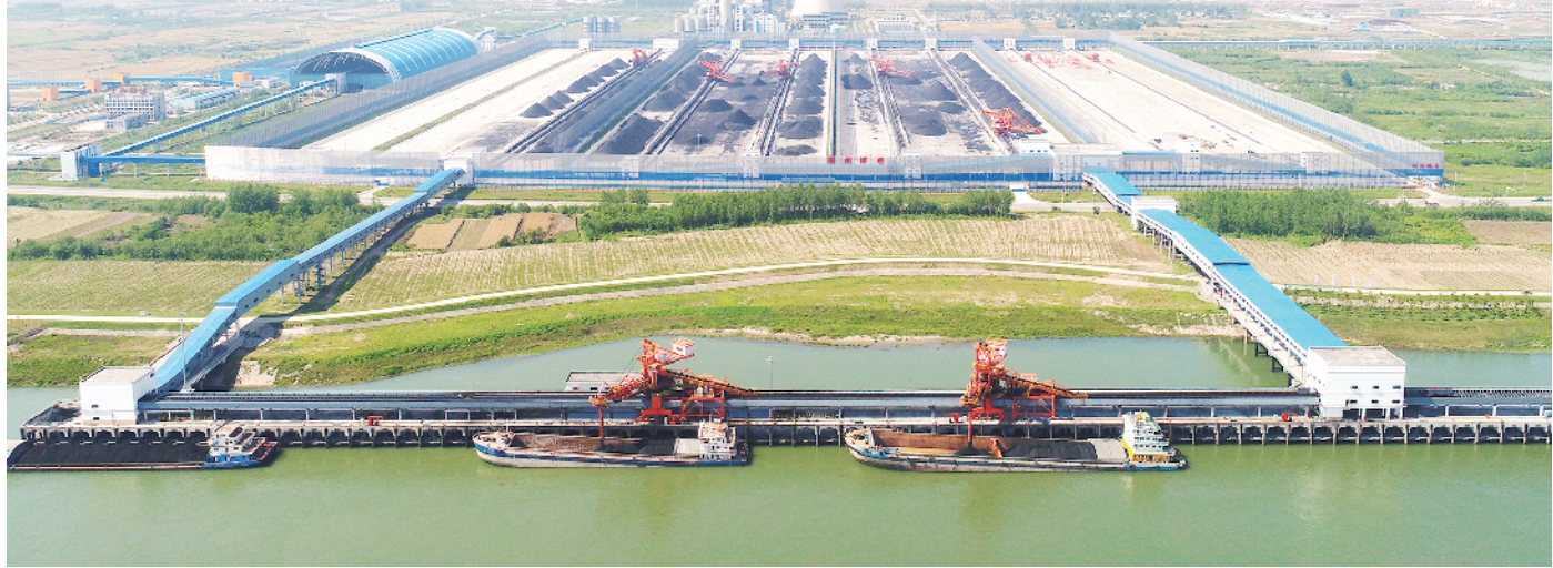
图为湖北荆州煤炭铁水联运储配基地。
