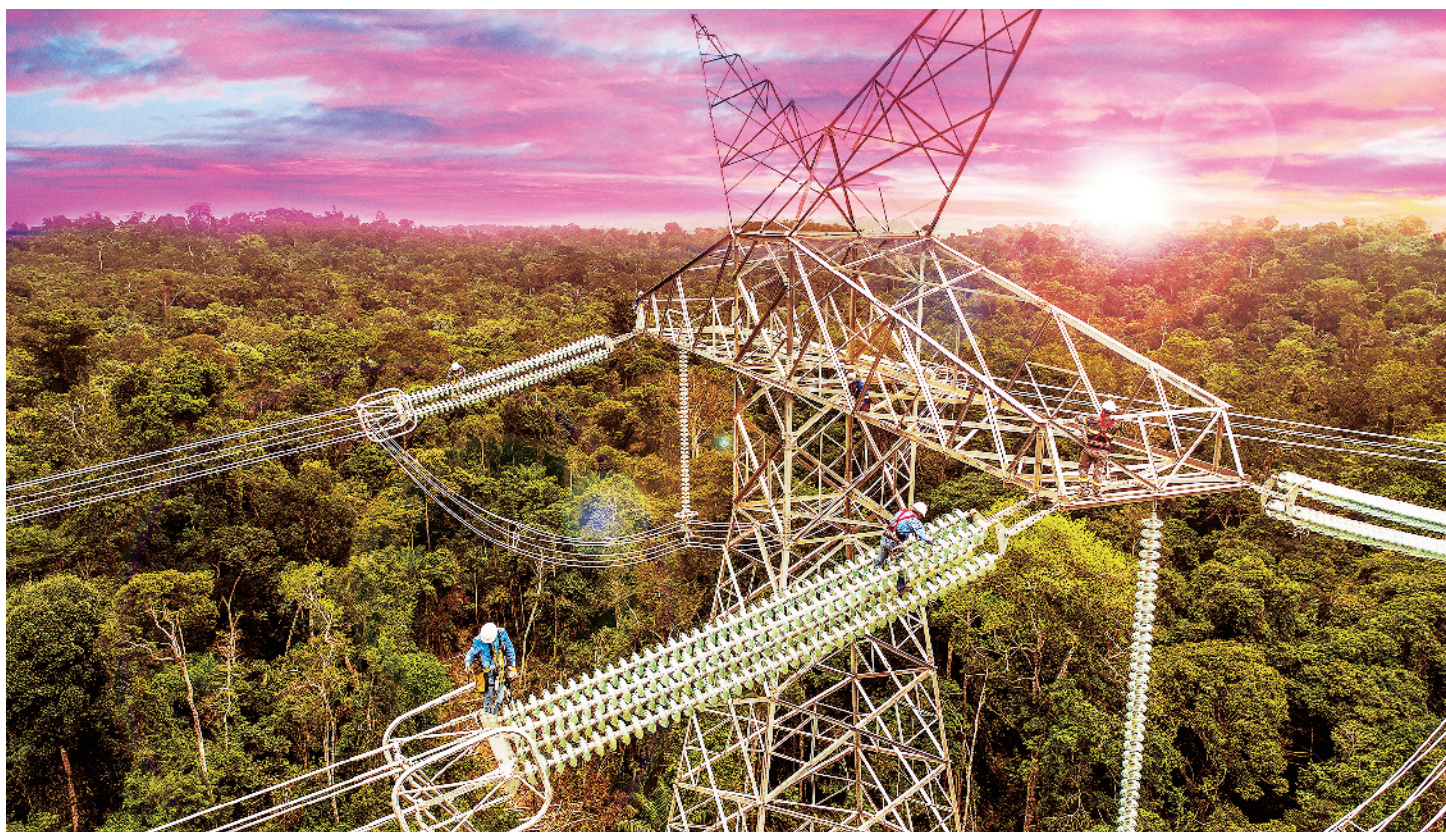
图为巴西美丽山±800 千伏特高压直流输电二期项目输电线路验收现场。 国网国际公司/供图
