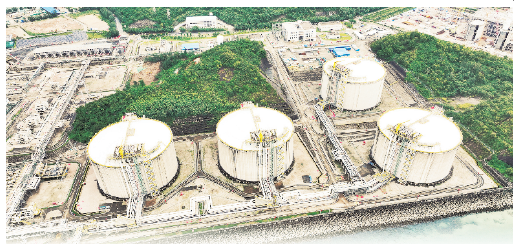
大鹏 LNG 接收站建有 4 个 16 万方的 LNG 储罐。中国海油/供图
