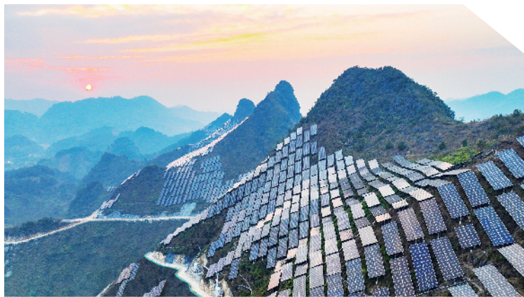
图为全国首例“大容量、高坡度”集中式山地光伏——广西田东光伏项目。
