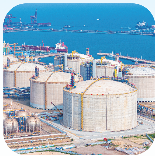
图片均为中国石化青岛液化天然气接收站场景。
