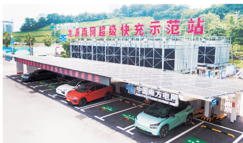
图为南宁国际会展中心龙源南网光储新能源超充示范项目。 梁磊/摄
