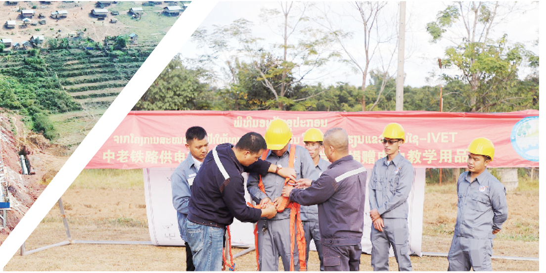
图为2020年11月27日，中老铁路老挝段外部供电项目向老挝乌多姆赛省综合职业技术学院捐赠电力教学用品并开展现场培训。
