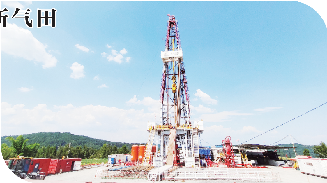
图为巴中气田正在钻进的评价井——元陆177X井作业现场。
