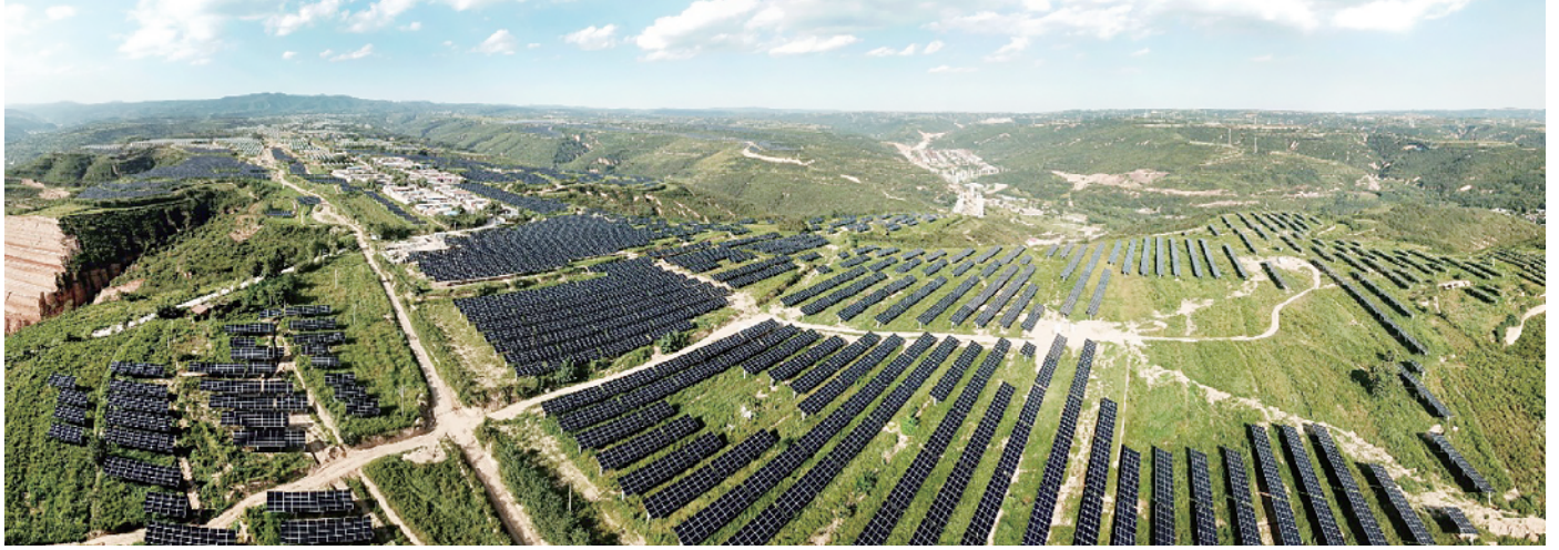
图为三峡集团铜川250MW光伏领跑者项目。隆基绿能/供图
