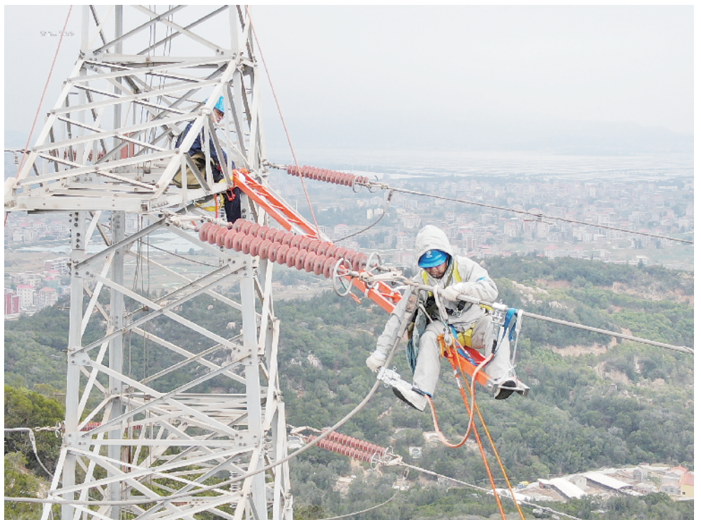
图为国网莆田供电公司员工带电消除线路缺陷,保障电网可靠运行。陈东武/摄
