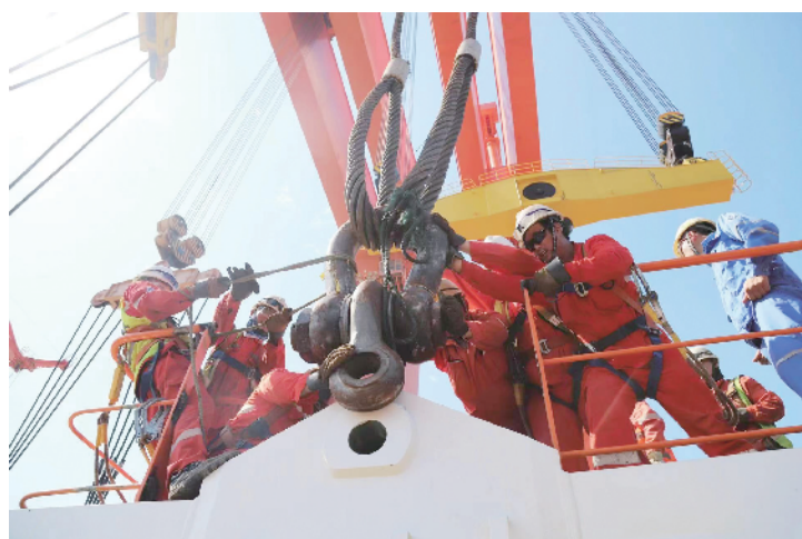
图为作业人员在现场通力合作紧张施工。中国海油/供图
