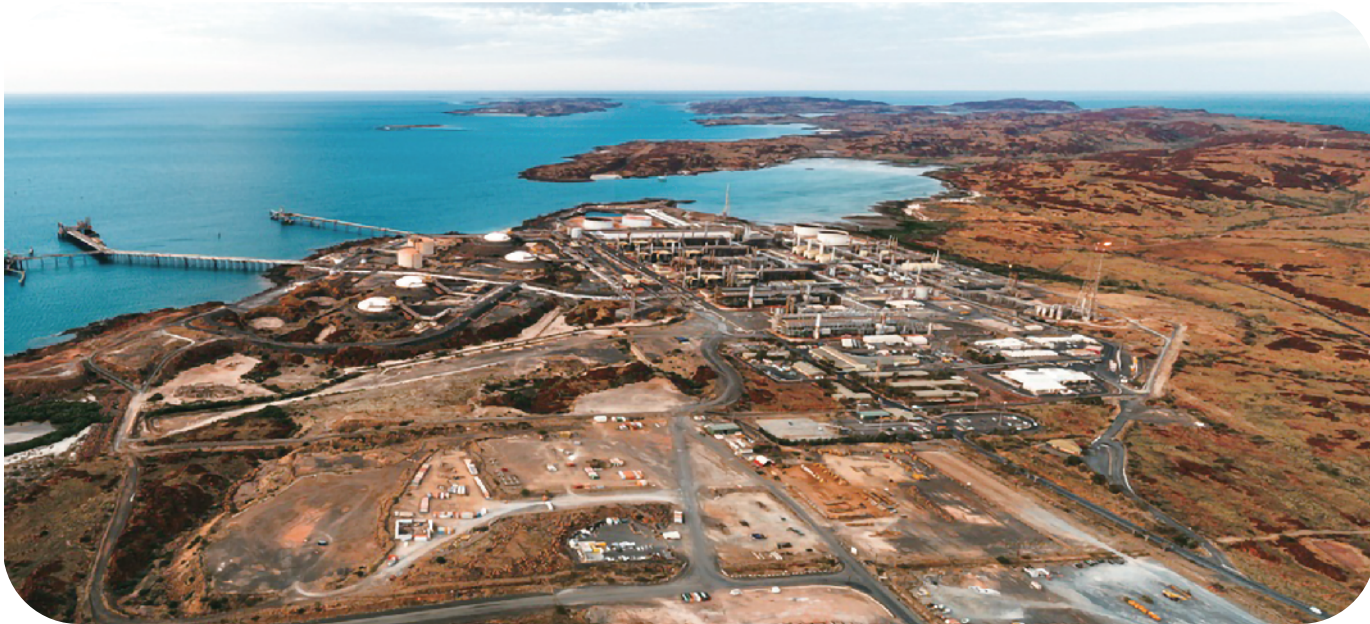
图为西北大陆架 LNG 项目。图片来源：伍德赛德公司官网
