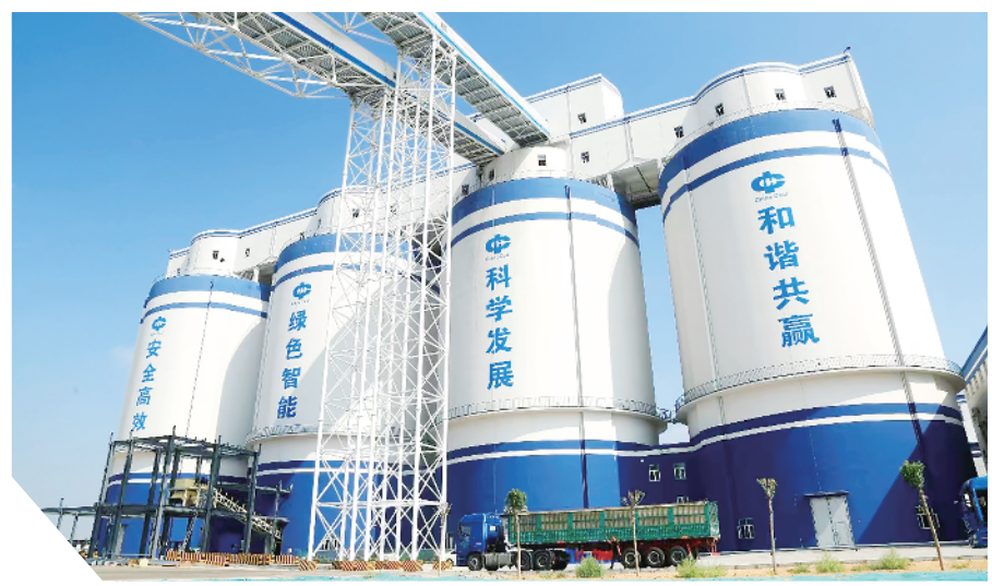
图为中煤陕西公司大海则煤矿选煤厂产品仓。
