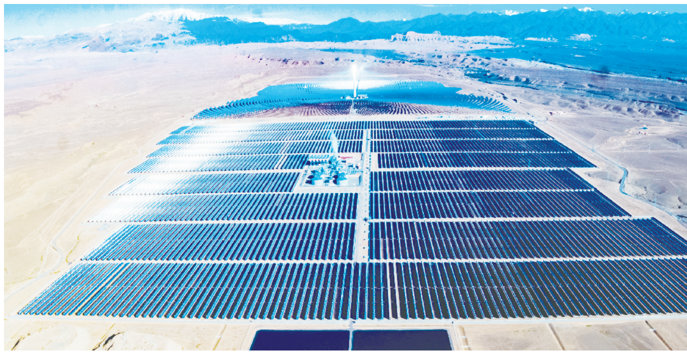
位于摩洛哥瓦尔扎扎特市的摩洛哥二期 200 兆瓦、三期 150 兆瓦光热电站工程是中国企业在海外建设的首个大型光热电站,该项目采用中国电站设备。
