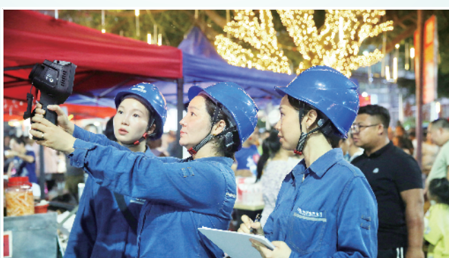
▲榕江供电局“巾帼班”成员正在开展变电设备测温工作。 胡乾/摄
