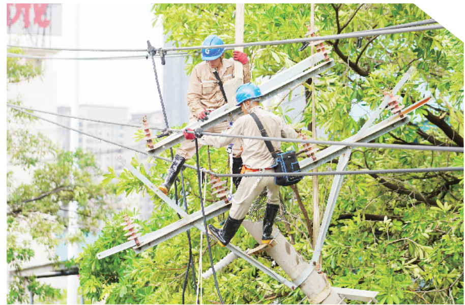
国网福建宁德供电公司组织抢修队支援抢修南安市创安国际石材广场工业区10千伏华宇线。 陈建豪/摄
