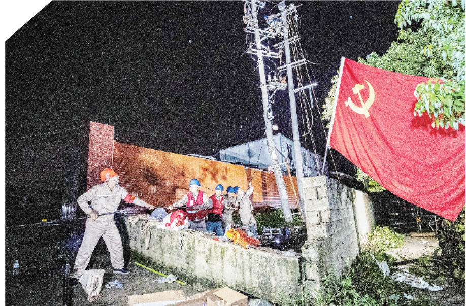
国网福建顺昌县供电公司支援抢险队伍对泉州丰泽区10千伏峰台线金鑫支线故障进行修复。 邓毅/摄
