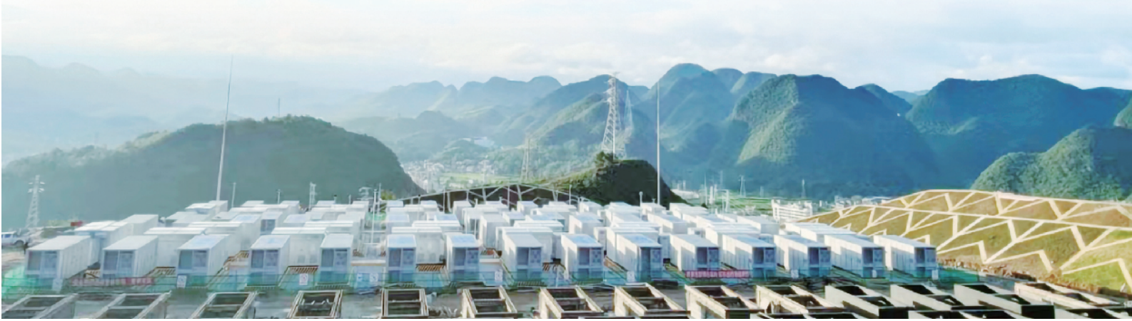
图为贵州省首个大型独立共享储能电站成功并网。黄晶/摄
