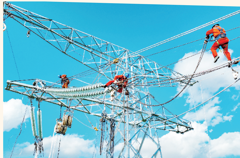
国网冀北电力职工头顶烈日在张北-白土窑500千伏线路上紧张作业。 李峥/摄
