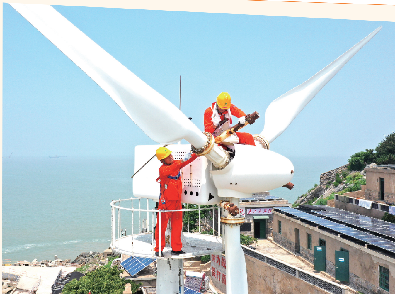
国网江苏连云港供电公司日前对开山岛智能微电网发电机组展开全面“体检”，保障微电网为海岛持续输出清洁绿色电能。图为连云港供电公司电力检修人员对风机叶片进行刮片换新。 任义刚/摄
