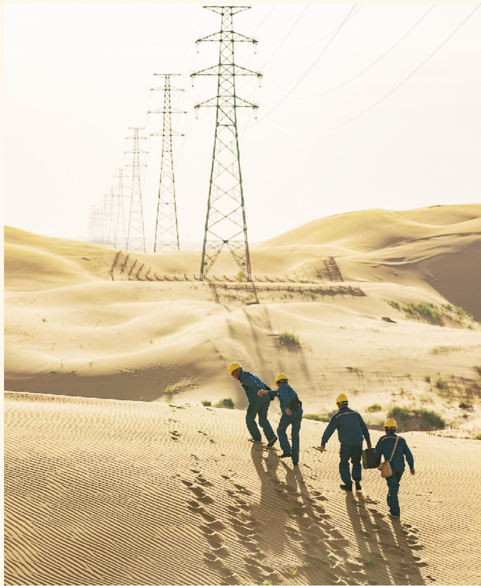
近日,在中国第七大沙漠——库布其沙漠,内蒙古电力集团鄂尔多斯供电公司输电人员克服高温天气影响,对位于沙漠腹地的铁塔线路进行特殊巡视,确保周边工业园区和民众可靠用电。 兰宁/摄
