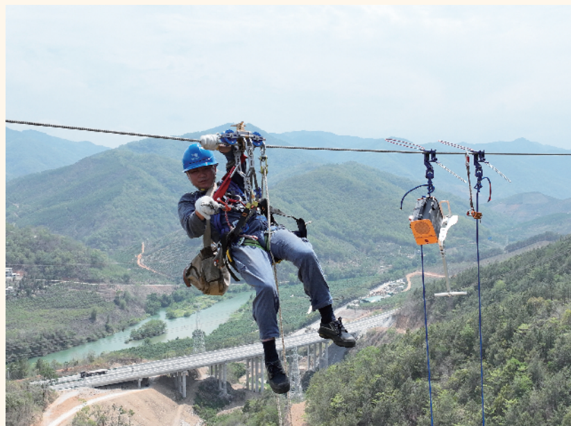
图为南方电网超高压公司天生桥局线路运维人员创新性地采用“人机结合”方法,处理500千伏西百甲线上的安全缺陷。代笠/摄
