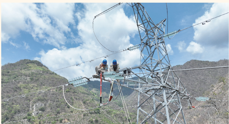
为提高输电线路可靠性,南方电网云南玉溪供电局输电管理所成立了输电网带作业专班。图为建设者对35千伏、110千伏、220千伏线路加装避雷器。徐文新/摄
