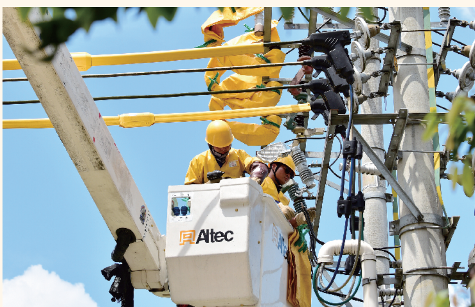
图为南方电网广西桂林临桂供电局工作人员在实施带电作业,提高供电可靠性。朱江/摄
