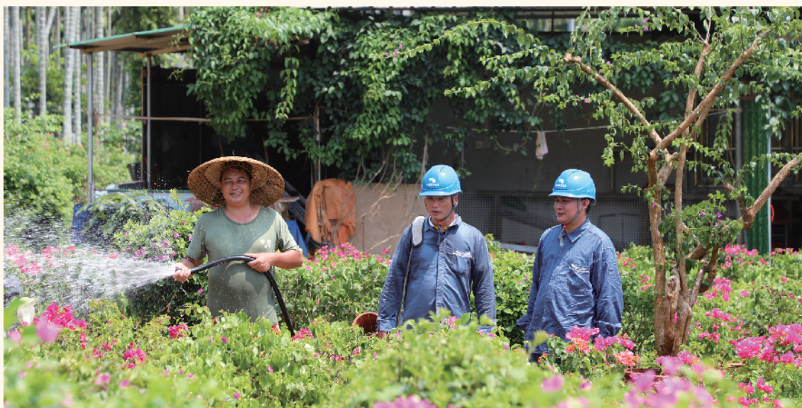
图为南方电网海南海口供电局工作人员到云龙花卉基地走访,旨在了解客户用电需求并对基地供电设备进行巡视测温,保障供电安全可靠。杨永光/摄
