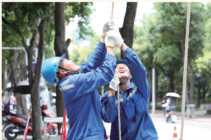
图为在贵州铜仁市印江县,南方电网贵州铜仁供电局工作人员顶着烈日进行设备隐患排查并及时消缺。向世杰/摄
