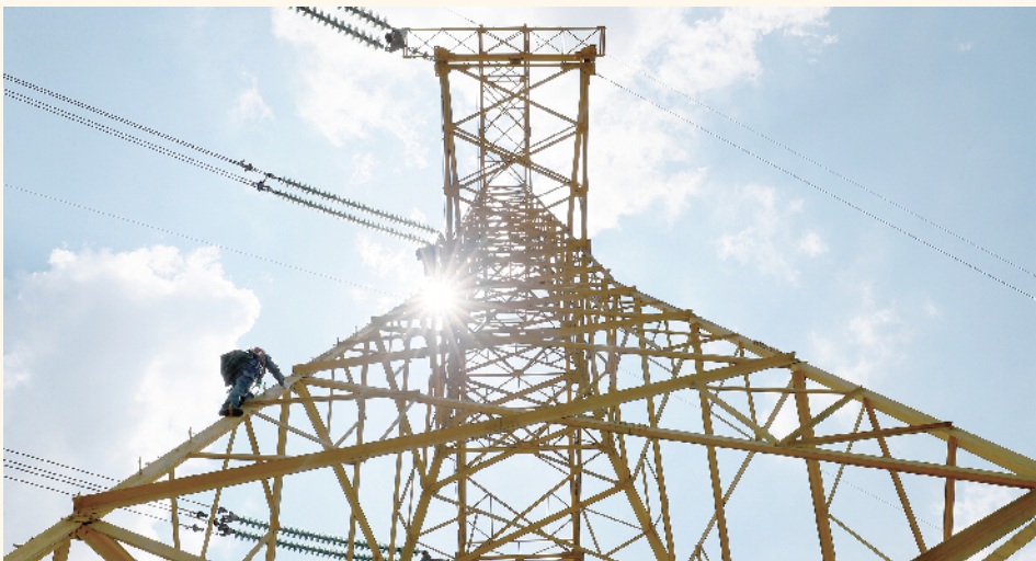
图为南方电网贵州兴义供电局工作人员头顶烈日进行登塔作业,对电网线路进行检修和维护,确保高温天气下电网安全稳定运行。卢关文/摄
