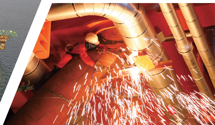
▼ 图为施工人员正在切割组块与船舶之间固定。
