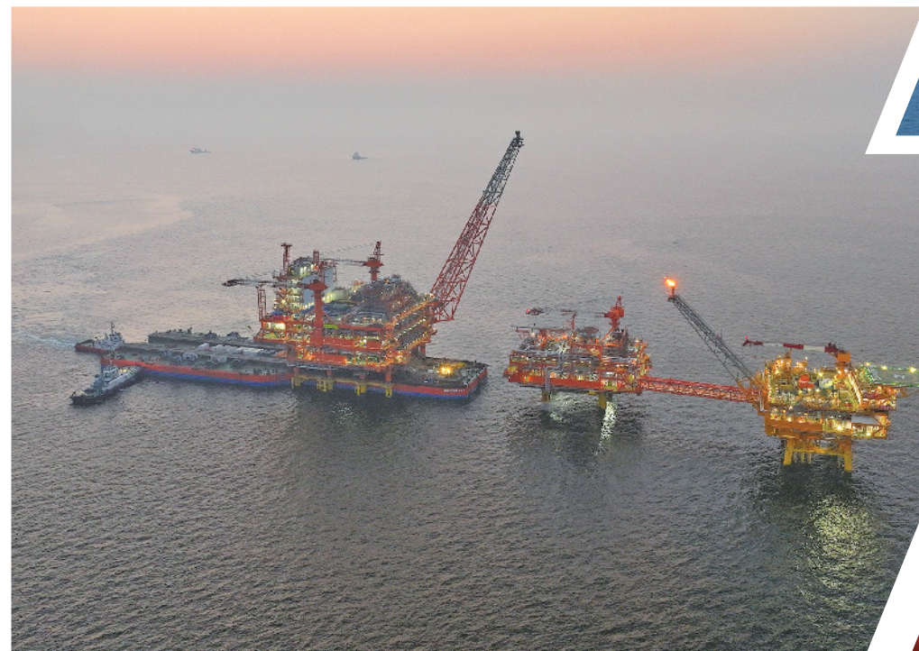
▲ 图为重达12000吨的上部组块与导管架精准对接。
