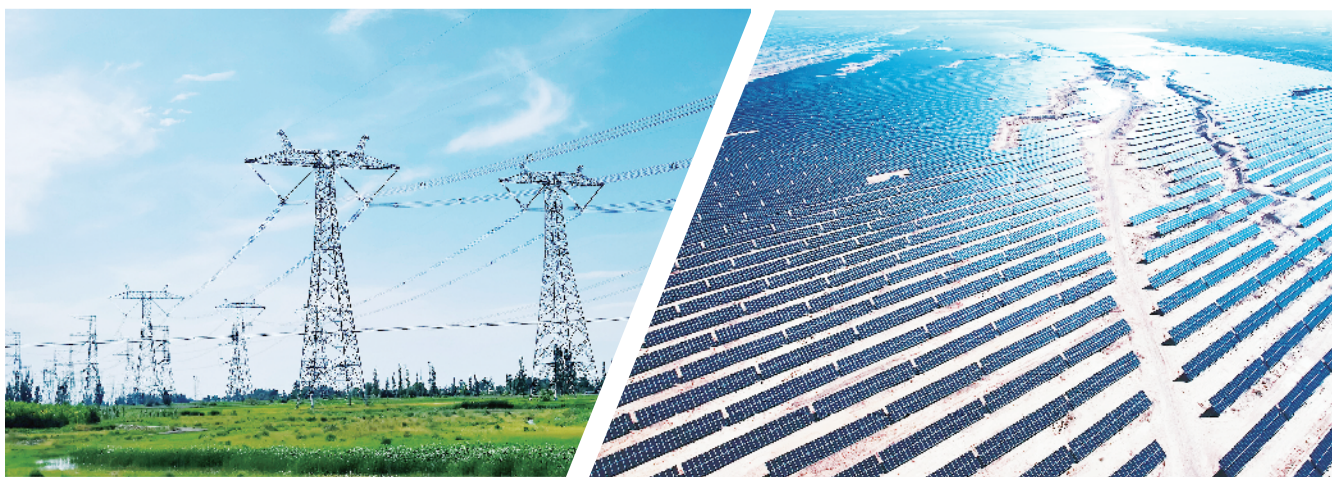
图为±1100 千伏吉泉直流、±800 千伏祁韶直流和天中直流在酒泉金塔县穿境而过。国网酒泉供电公司/供图
