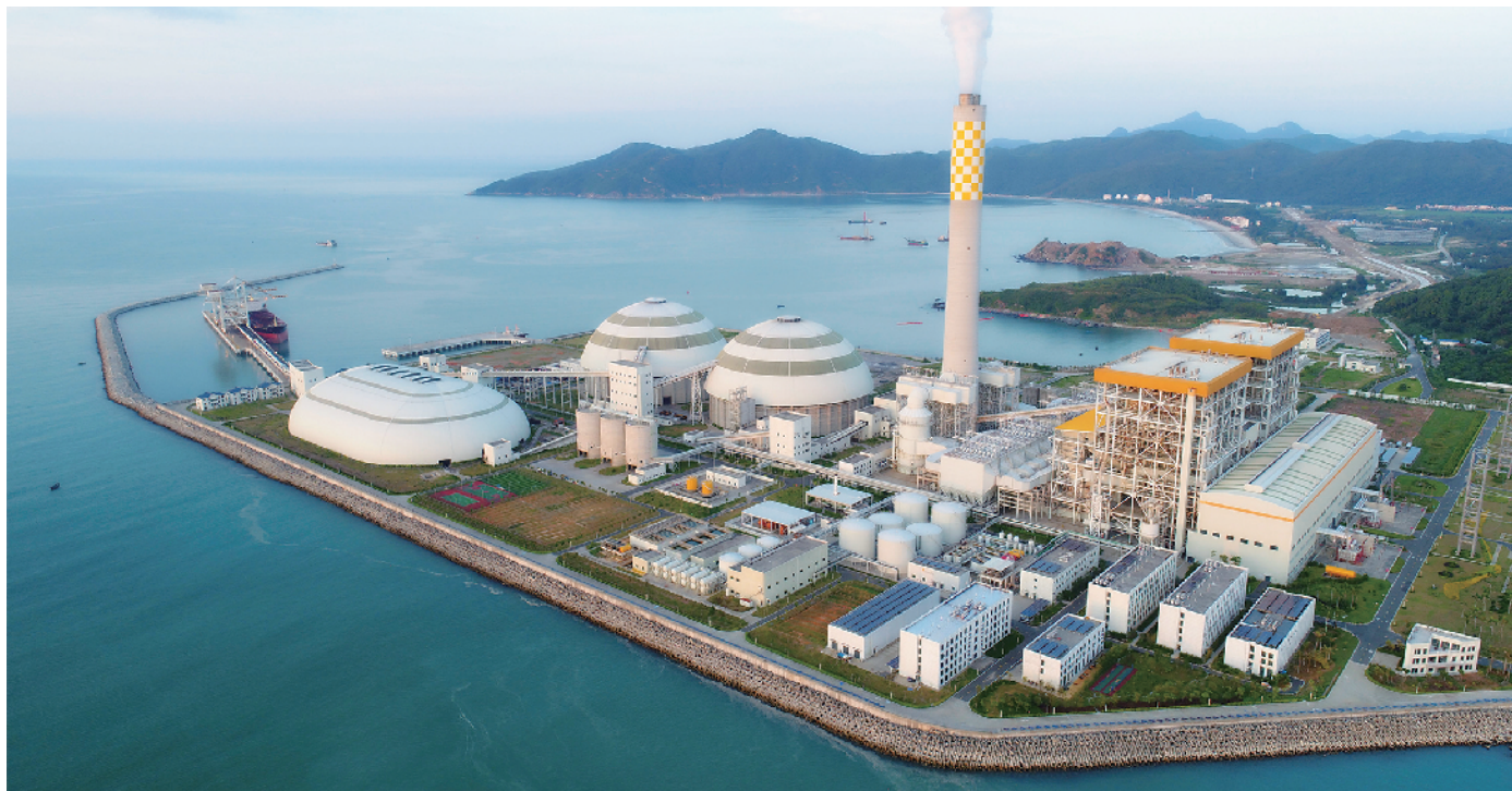
图为华润海丰电厂国家碳捕集示范工程,亚洲首个多线程碳捕集测试平台。中国能建/供图
