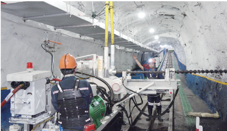
图为山东能源李楼煤矿应用了盘古矿山大模型的防冲卸压现场。山东能源/供图
