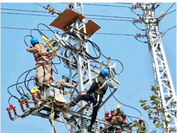
图为昆明禄劝供电局按项目作业计划,组织开展10千伏中屏集镇线2号塔配电自动化改造设备安装。 龙振江/摄
