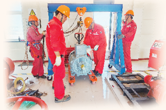
图为生产运维项目部员工正在吊装消防水泵电机。
