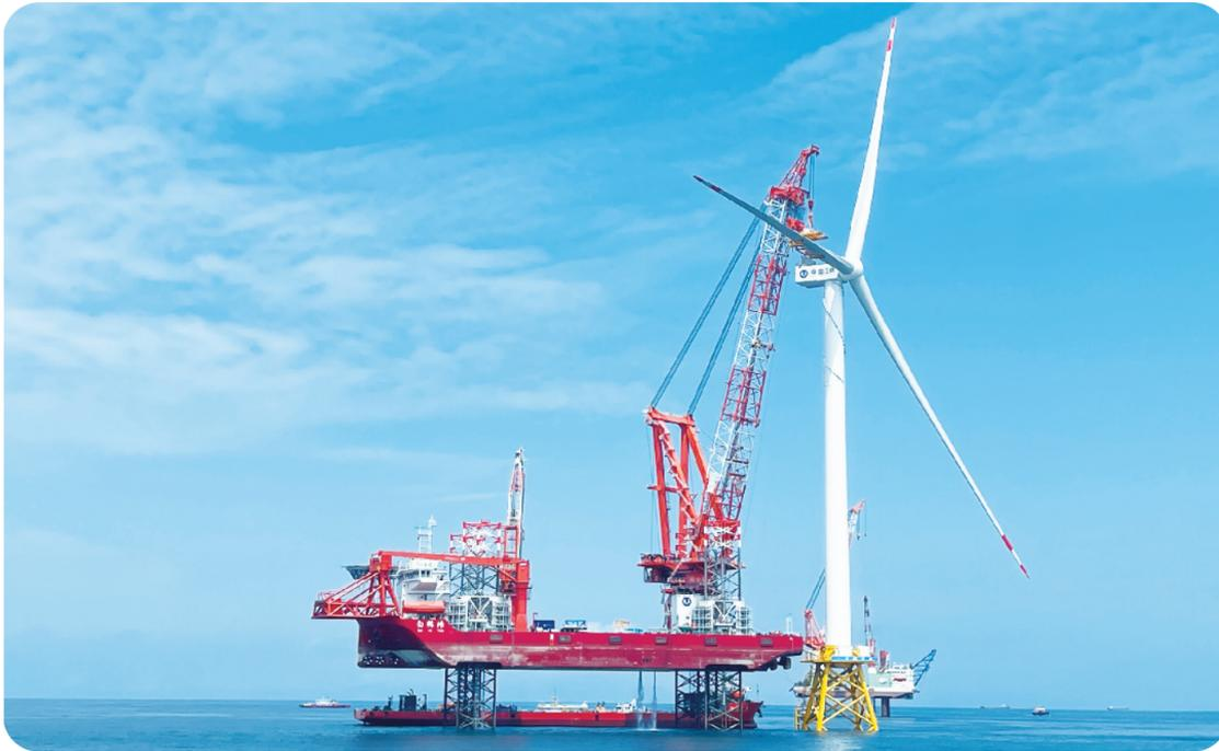
图为首台16兆瓦海上风电机组吊装情形。苏南/摄
