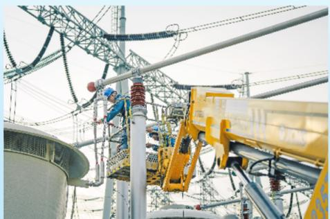
图为世界单套容量最大STATCOM装置安装现场
