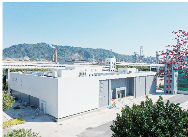
图为广州石化炼油中心控制室。
