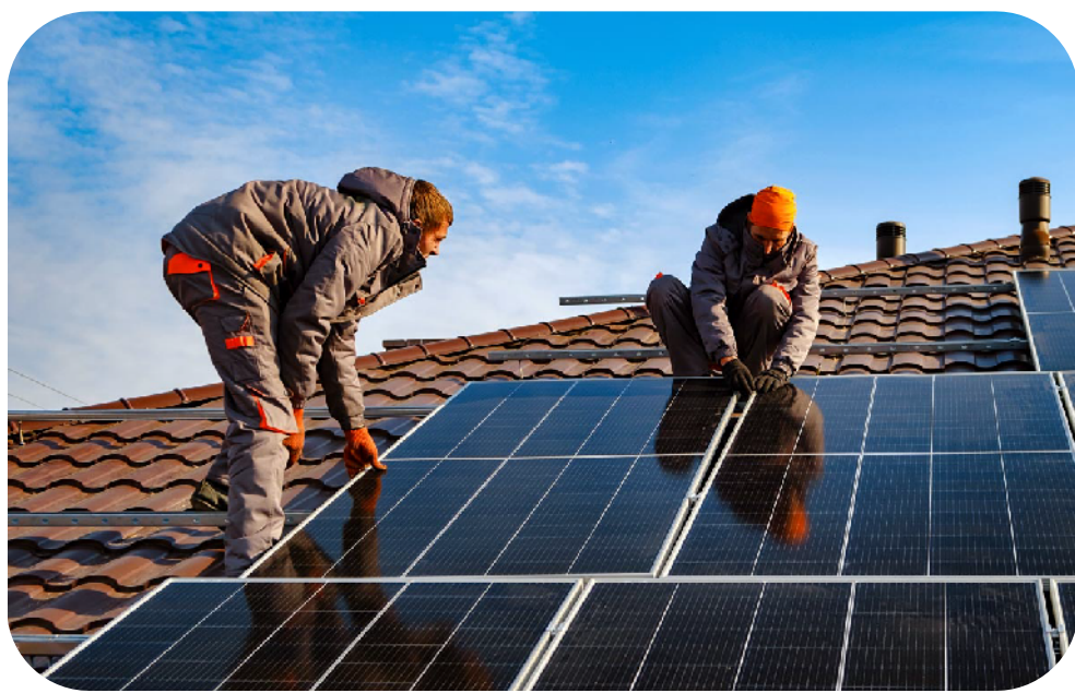
图为工人正在英国一处屋顶安装光伏板。英国屋顶光伏协会供图
