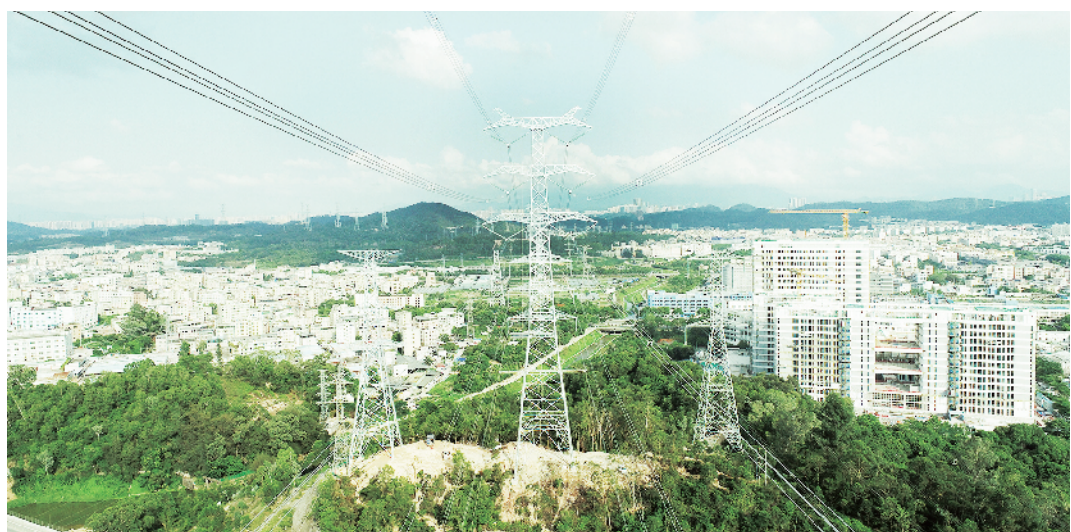
图为广东省及南方电网重点项目——500千伏核鲲鹏工程。彭鹏/摄
