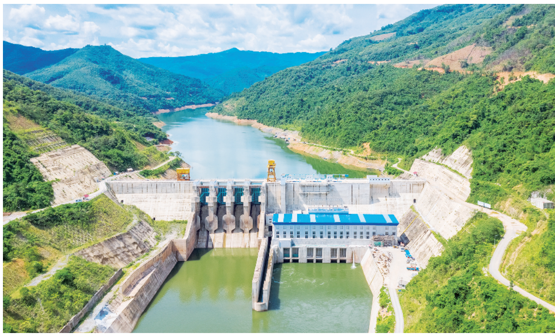
中国电建建设运营的老挝南欧江梯级水电站。桑文林/摄
