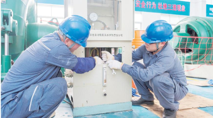
图为靖西供电公司工作人员在岷牌发电站对调整器进行检修维护。骆衍利/摄
