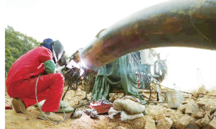
气田集输管道焊接现场。王忠涛/摄
