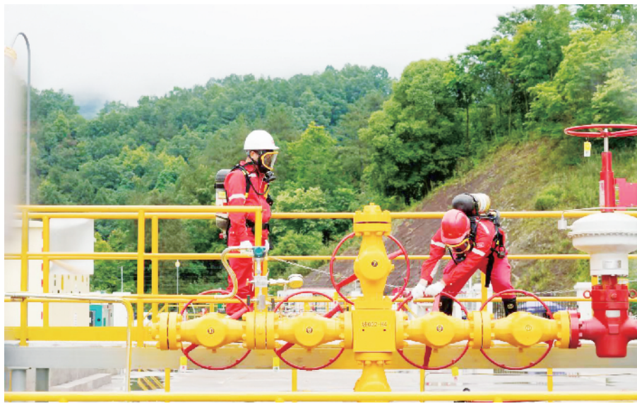
气井开井现场。韩超/摄
