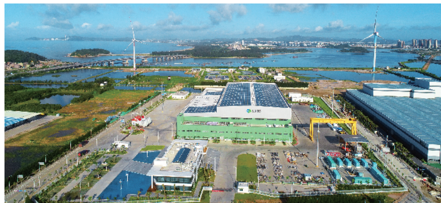
图为配套 2MW/2MWh 储能系统的汕头智慧能源系统示范项目，其中 1MW/1MWh 储能系统采用全钒液流电池储能系统。
