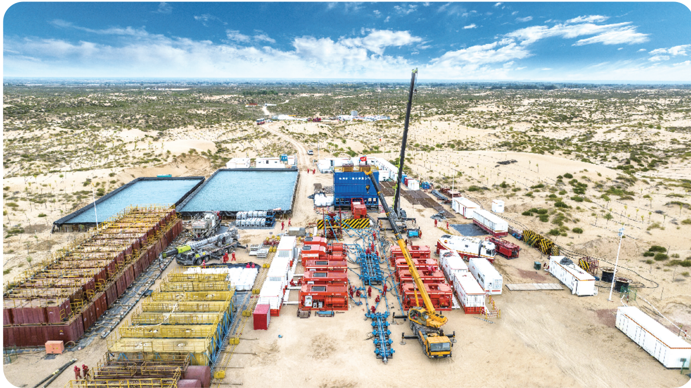
杰瑞大功率电驱压裂设备在井场作业。杰瑞/供图
