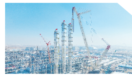
2月22日,位于固阳县金山工业园区的弘元能源科技(包头)有限公司项目建设现场,从高空俯瞰正在建设的精馏塔。贾荣/摄
