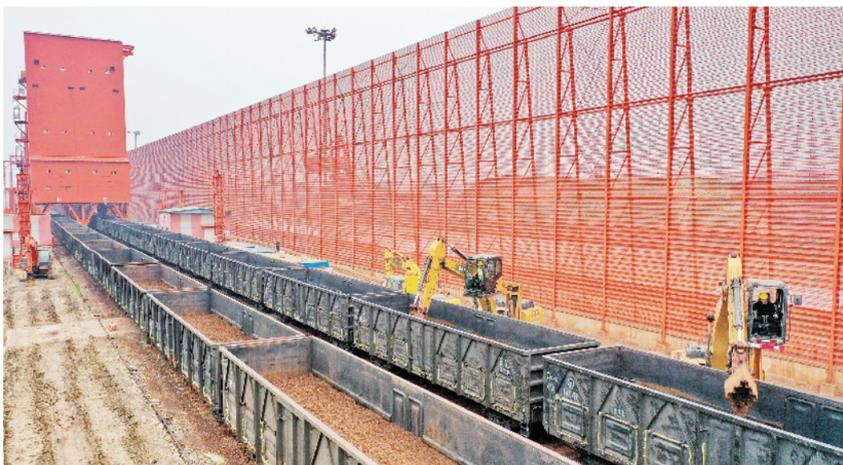
图为在河北曹妃甸港区，工作人员操作设备对装有铁矿石的车皮进行压实。
