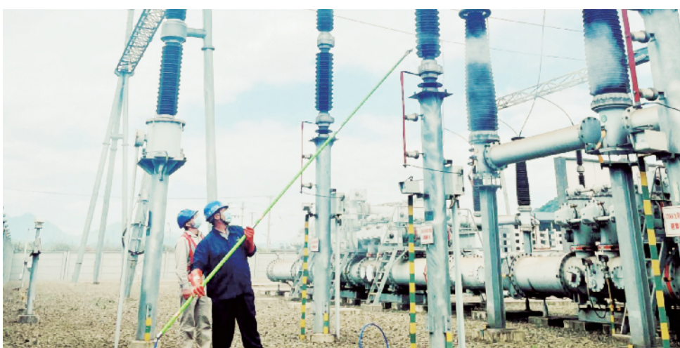
图为国网南平供电公司变电检修中心对政和县220千伏同心变一次设备开展带电冲洗作业。
